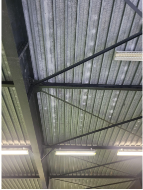
Bac acier de toiture de la salle A
